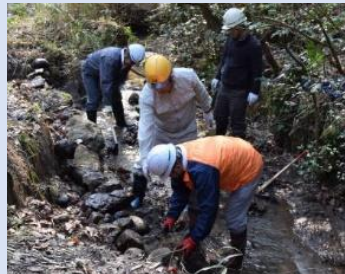
川岸の石垣補修工事
